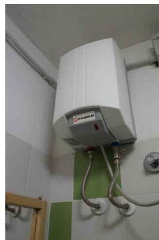
Figura 4.15 - Particolare della caldaia murale a gas installata in cucina per la produzione di acqua calda sanitaria
